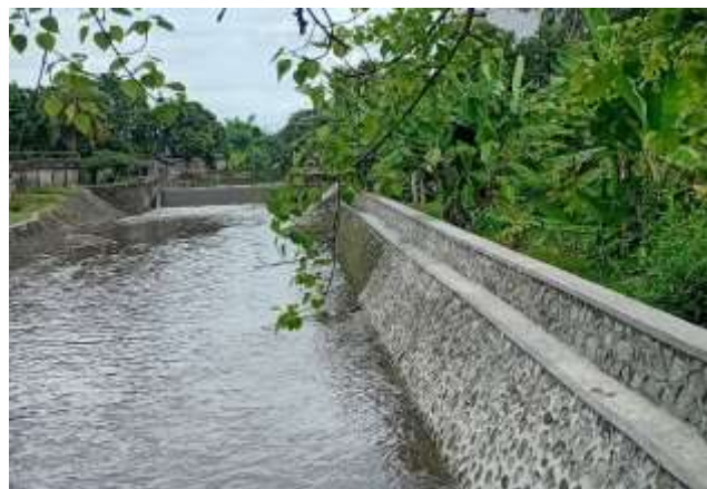
Gambar 1 Dinding pelindung Sungai Unus Dokumentasi penulis ( 2026)
