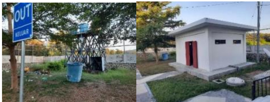
Gambar 4.4. Bangunan Pompa Air dan Menara Reservoir Air di Area PLBN Motaain
