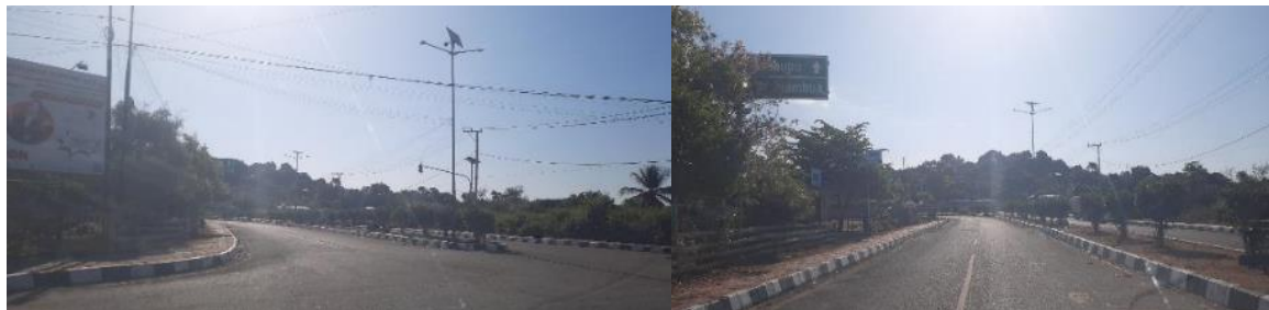
Gambar 4.10 Kondisi Jaringan Jalan Arteri Primer Nasional Trans Timor di Ujung Gerbang PLBN Motaain di Desa Silawan Sumber: Hasil Observasi Peneliti, 2024
