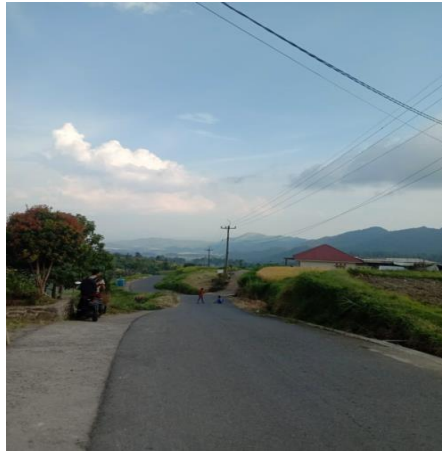
Gambar 3. Kondisi jalan Di Kawasan Wisata Nagari Tuo Pariangan
